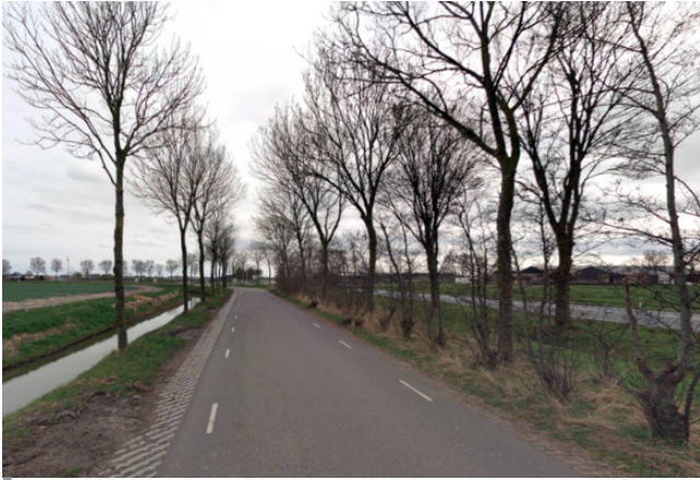
Voorbeeldinrichting erftoegangsweg buiten de bebouwde kom, 60 kilometer per uur
